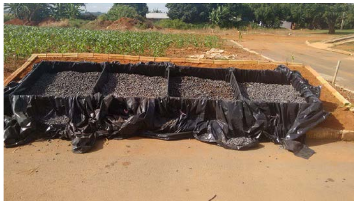
Figura 2: Primeiro passo da montagem dos pavimentos.
