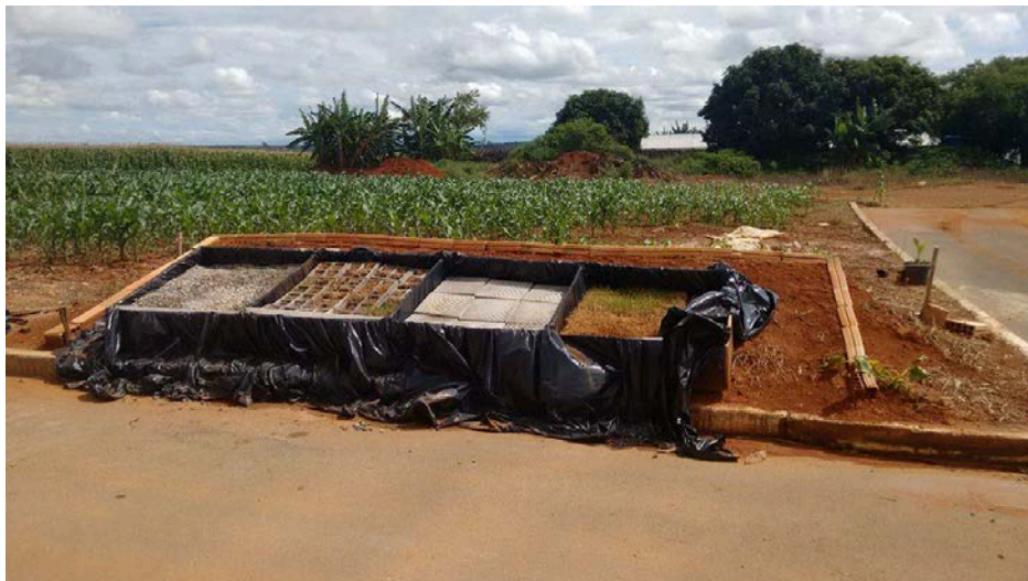
Figura 3: Segundo passo da montagem dos pavimentos.
